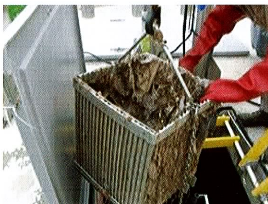
Poste de refoulement – panier rempli de lingette qui doit être vidé toutes les trois semaines – manutention des agents d'entretien
