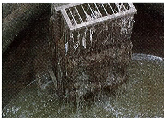
Poste de refoulement – panier rempli de lingette qui doit être vidé toutes les trois semaines – manutention des agents d'entretien
